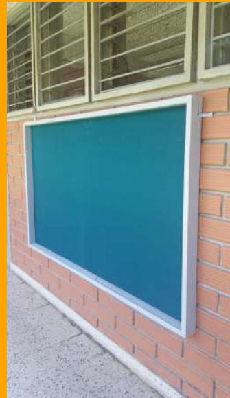
Reparación de carteleras
