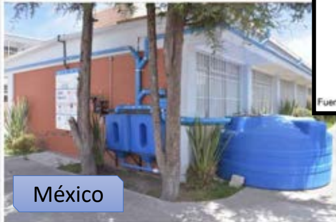
Sistema de Captación de Agua Pluvial en escuelas públicas
