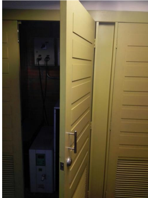
Tipo de puerta que debe tener el nicho, con el soporte en marco metálico
