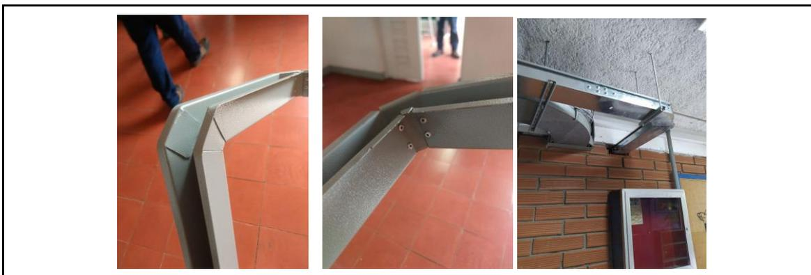
No se recibirán ductos con tornillos que puedan dañar a la integridad del cable. La tornillería a usar será de tipo “autoperforante”.
