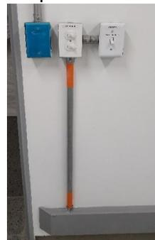
Los tornillos de sujeción de las tapas de las cajas (terminación y de paso) deben ser del mismo color y tipo, con el fin de manejar una buena estética en las instalaciones.
