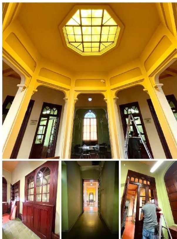
Restauración de carpintería Edificio Manuel Uribe Ángel y Edificio Andrés Posada Arango
