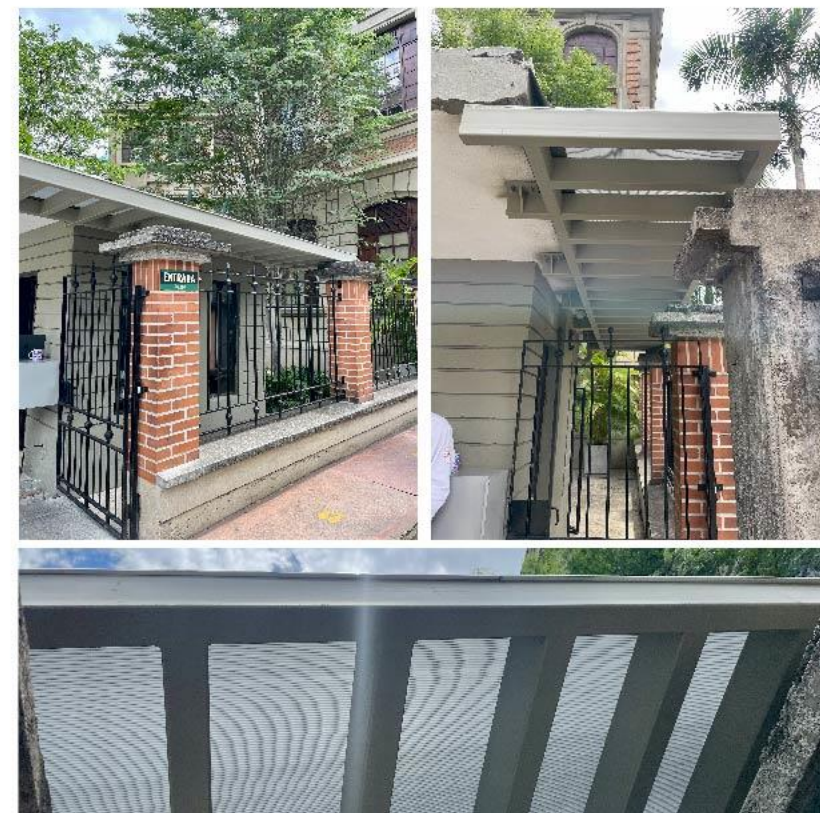
Instalación y adecuación de cubierta portería principal
