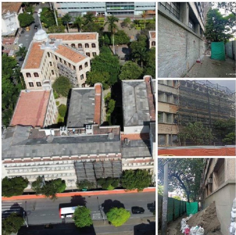
Restauración de la fachada Avenida Carabobo
