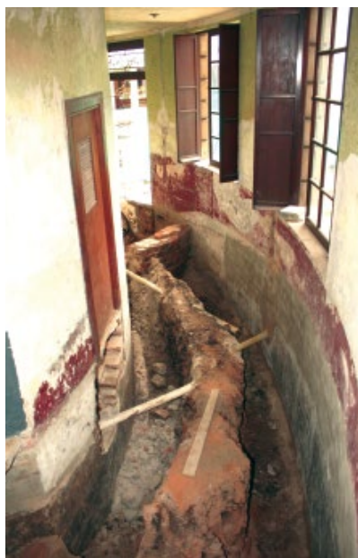
Para lograr durabilidad en la pintura aplicada sobre muros y cielos, se liberaron todas las capas no originales aplicadas sobre la superficie. Por otro lado se instalaron nuevos ductos para redes, tubería y cámaras para ventilación
