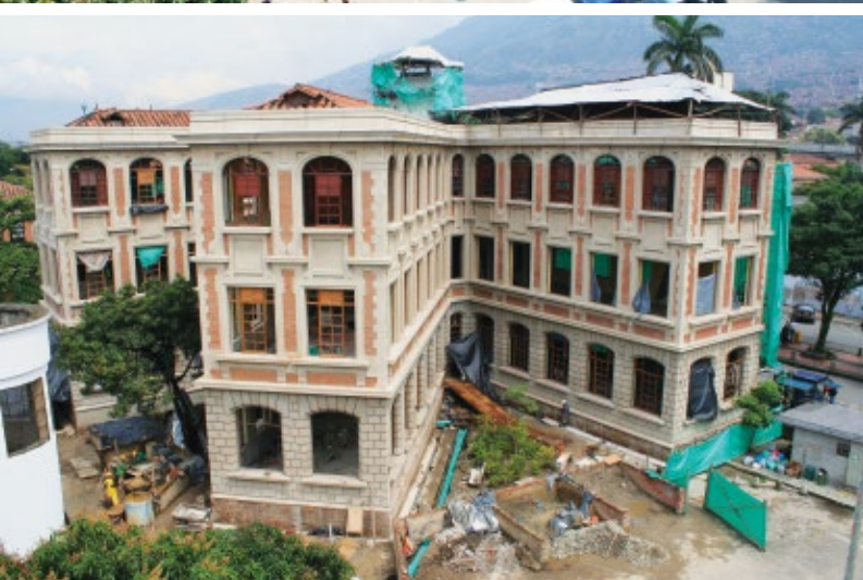
Fotografías del antes, durante y después de las obras. En 2006, la Facultad incluyó en su Plan de Acción, la restauración del antiguo edificio de Bioquímica diseñado por Agustín Goovarts y construido entre 1926-1929. La estructura estaba casi en ruinas, las ventanas eran cubiertas con plásticos, la humedad invadía la mayoría de espacios y las condiciones de bienestar para la comunidad universitaria eran mínimas
