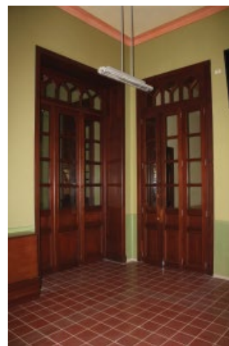
Todos los elementos de madera, como ventanas, puertas y muebles, fueron restaurados teniendo en cuenta cada detalle. Se liberaron piezas no originales, cambios de elementos como bisagras y se aplicaron capas de pintura para armonizarlas de acuerdo a la estética del edificio. Imágenes del antes, durante y después de las obras
