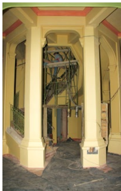
Los revoques tenían fisuras y estaban afectados por la humedad. Con las obras se determinaron y reemplazaron los colores y partes originales de muros, cielos y elementos de madera
