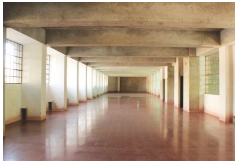
Nuevo espacio para la ubicación de la Biblioteca Médica. Primer piso del Edificio Central, 2014
