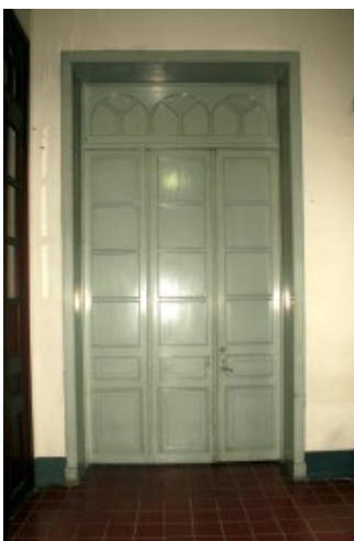
Todos los elementos de madera, como ventanas, puertas y muebles, fueron restaurados teniendo en cuenta cada detalle. Se liberaron piezas no originales, cambios de elementos como bisagras y se aplicaron capas de pintura para armonizarlas de acuerdo a la estética del edificio. Imágenes del antes, durante y después de las obras
