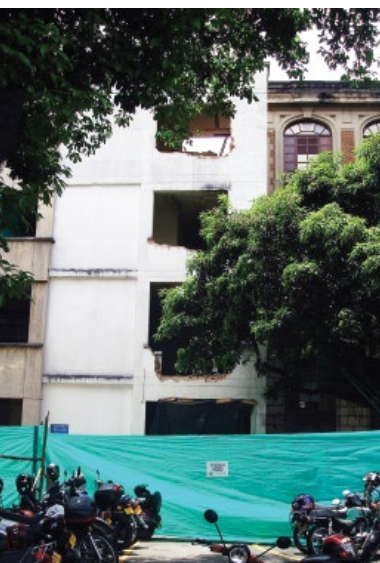
Cerca de 1965 se construyó una estructura entre los edificios central y el antiguo de Bioquímica, deteriorando la estructura de este último. Con la restauración, se demolió la edificación "intrusa" y se recuperó la arquitectura original de los diferentes edificios de la Facultad, respetando las obras construidas en diferentes momentos
