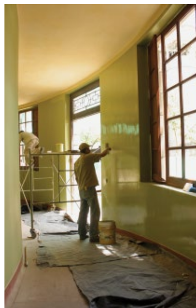
Para lograr durabilidad en la pintura aplicada sobre muros y cielos, se liberaron todas las capas no originales aplicadas sobre la superficie. Por otro lado se instalaron nuevos ductos para redes, tubería y cámaras para ventilación
