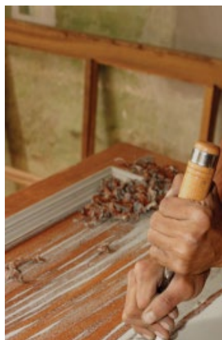
Todos los elementos de madera, como ventanas, puertas y muebles, fueron restaurados teniendo en cuenta cada detalle. Se liberaron piezas no originales, cambios de elementos como bisagras y se aplicaron capas de pintura para armonizarlas de acuerdo a la estética del edificio. Imágenes del antes, durante y después de las obras
