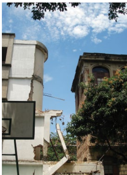
Cerca de 1965 se construyó una estructura entre los edificios central y el antiguo de Bioquímica, deteriorando la estructura de este último. Con la restauración, se demolió la edificación "intrusa" y se recuperó la arquitectura original de los diferentes edificios de la Facultad, respetando las obras construidas en diferentes momentos
