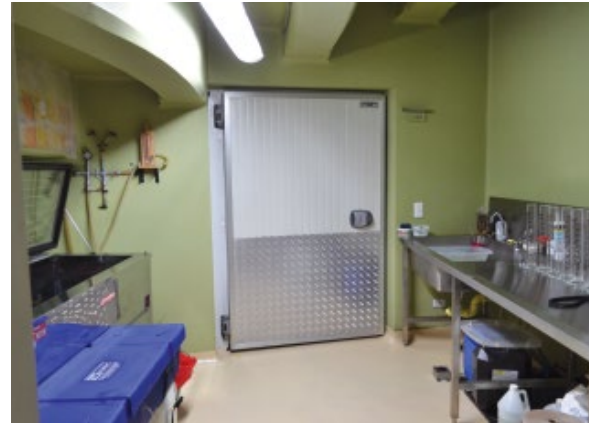
Estado inicial y final del depósito de cadáveres, antigua morgue. Montaje de cavas de enfriamiento y de congelación, instalación de estantería para almacenamiento de cuerpos y piezas anatómicas
