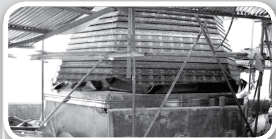
Estructura impermeabilizada, se adicionan listones para el soporte de lámina troquelada
