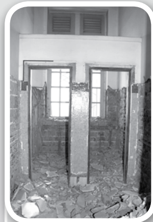
Demolición de baños públicos
