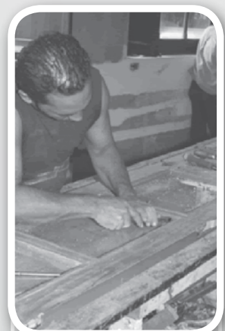
Proceso de restauración de marcos y de ventanas
