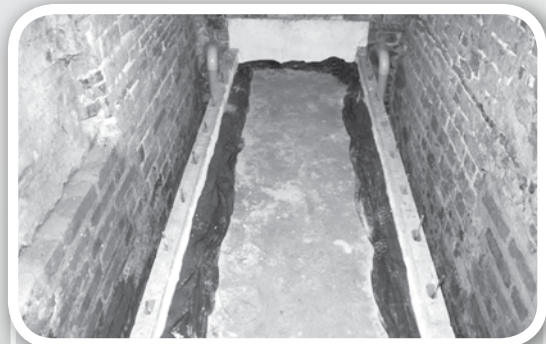
Instalación de cámaras de aire
