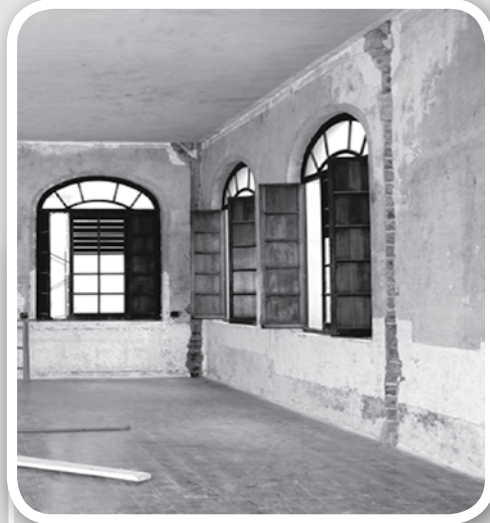
Liberación de capas de pintura en muros y cielos rasos
