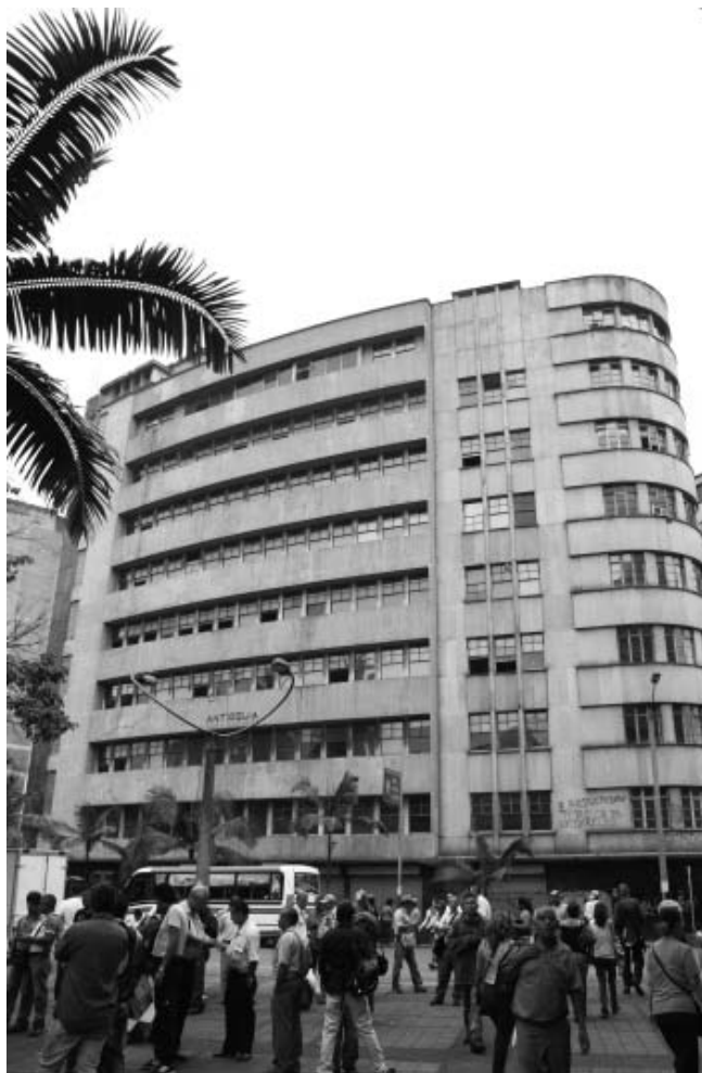
Fachada del Edificio Antioquia. Foto de Óscar Darío Correa G.
