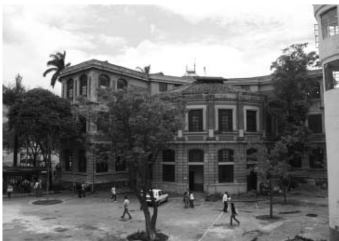
Edificio Andrés Posada Arango
