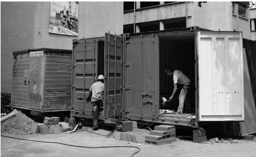
Adecuación de baños públicos temporales
