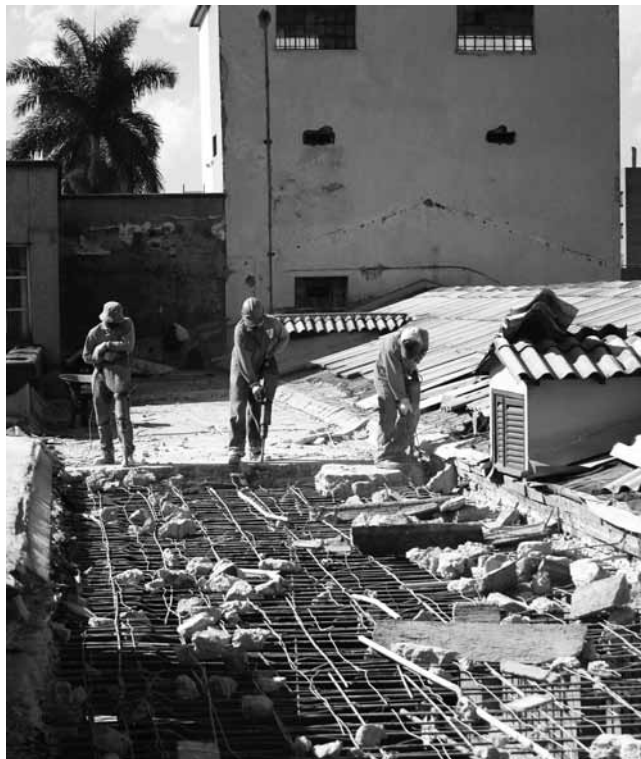
Demolición losa 3º piso
