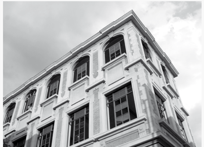
Detalle ornamental en fachadas exteriores del Edificio Histórico Manuel Uribe Ángel. Obsérvese la recuperación de cornisas, molduras y ventanas en madera.
