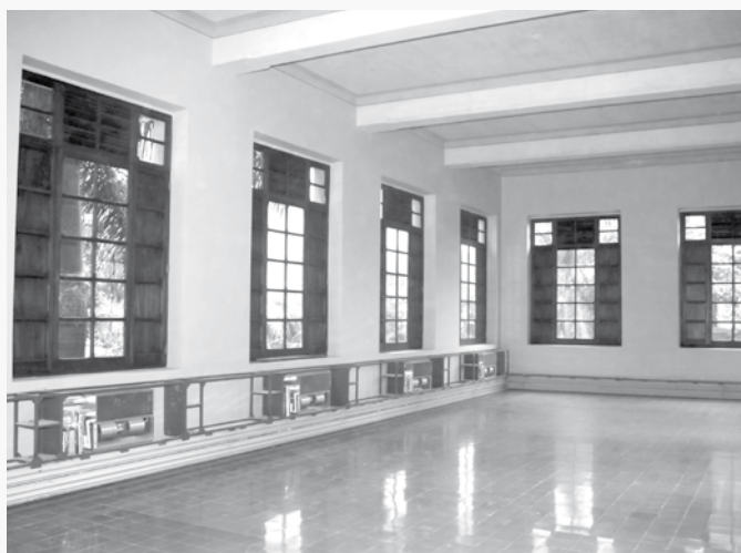
Vista interior de la nave central, segundo piso, del Edificio Histórico Manuel Uribe Ángel. Restaurado en pisos, muros, ventanas en madera y cielo raso. Dotación de redes eléctricas y estructuradas y sistemas de aire acondicionado (en proceso de instalación).
