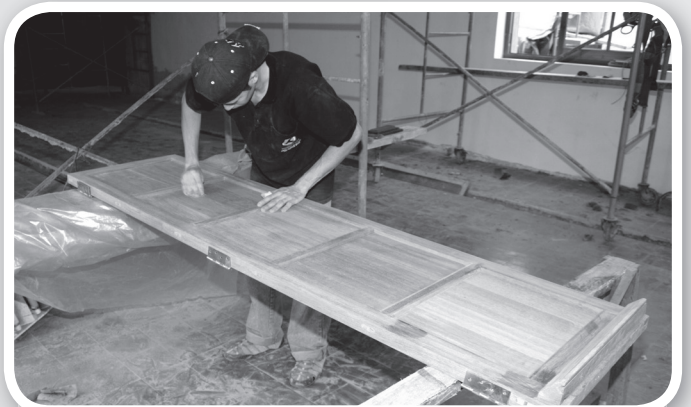
Luego de liberada la pintura y hechos los reintegros de madera, se pule la superficie con diferentes calibres de lija
