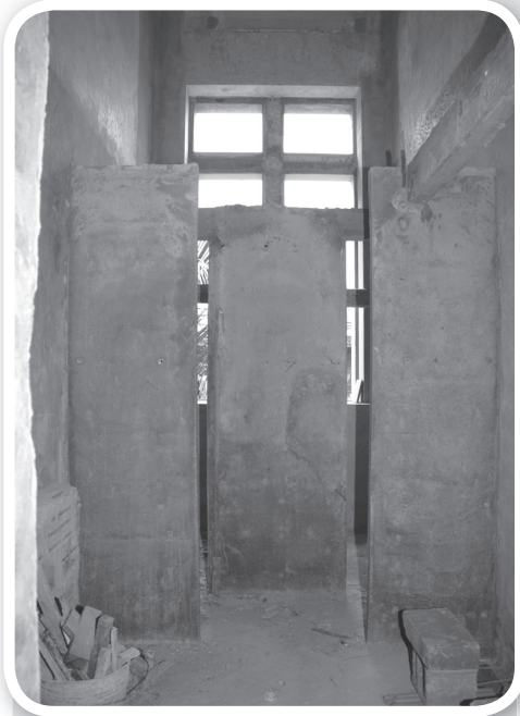
Muros en concreto reforzado en los baños
