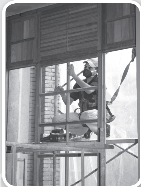
Intervención de las ventanas del auditorio.
