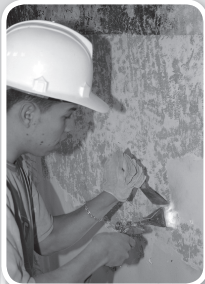
Liberación de capas de pintura con aplicación de calor
