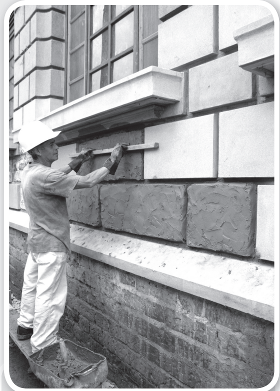
Revoque de la fachada exterior del Edificio de Morfología
