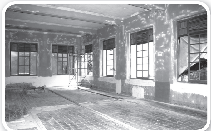
Resane de la superficie y aplicación de primeras capas de pintura en cielos y muros
