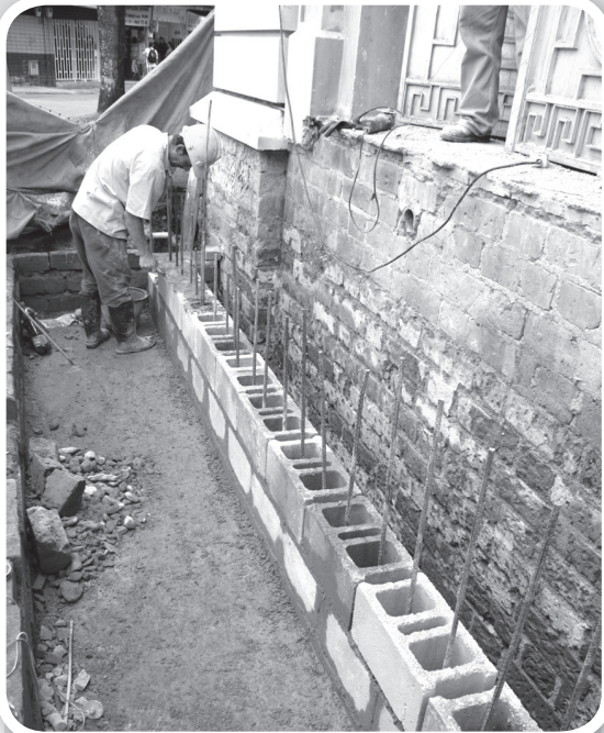
Muro en bloque con refuerzo vertical para la cámara y losa superior. Cada cámara contiene sus respectivos filtros, entradas, salidas, conexiones y rejillas en las entradas y salidas.
