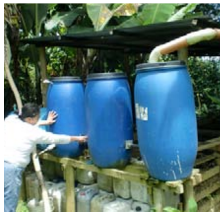
Montaje para coleccionar agua lluvia para la elaboracion de biopreparados, Vivero Frutyarte, Gilma Lucía Arango, San Antonio de Prado.
