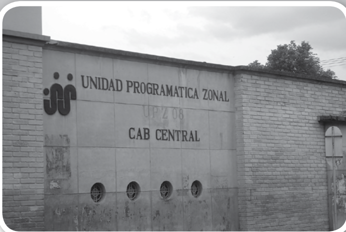
Antiguo Centro de Atención Básica del Instituto de Seguro Social —CAB del ISS—, espacio donde se construirá el Parque de la Vida
