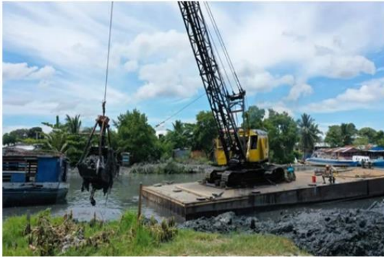
Figura 13. Actividad de dragado del canal
